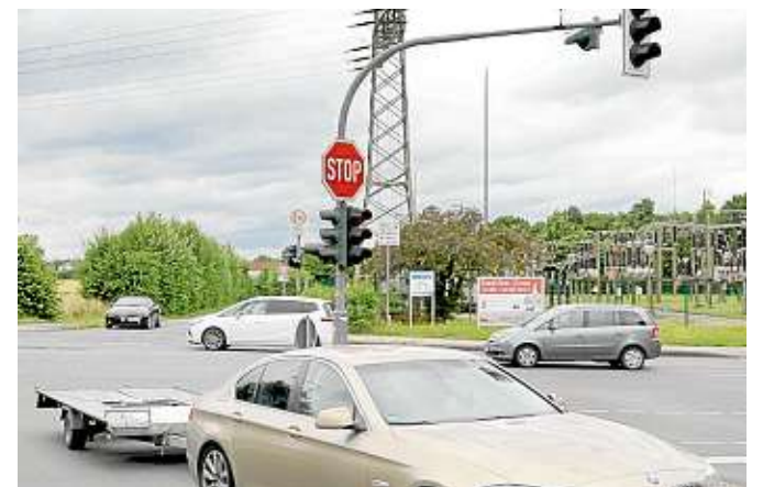
Der geplante Umbau der Kreuzung Hansastraße/Hochstraße mit einem Kreisell ist ein Einzelprojekt, aber auch Teil des Systems Westtangente. ■ Foto: Archiv
